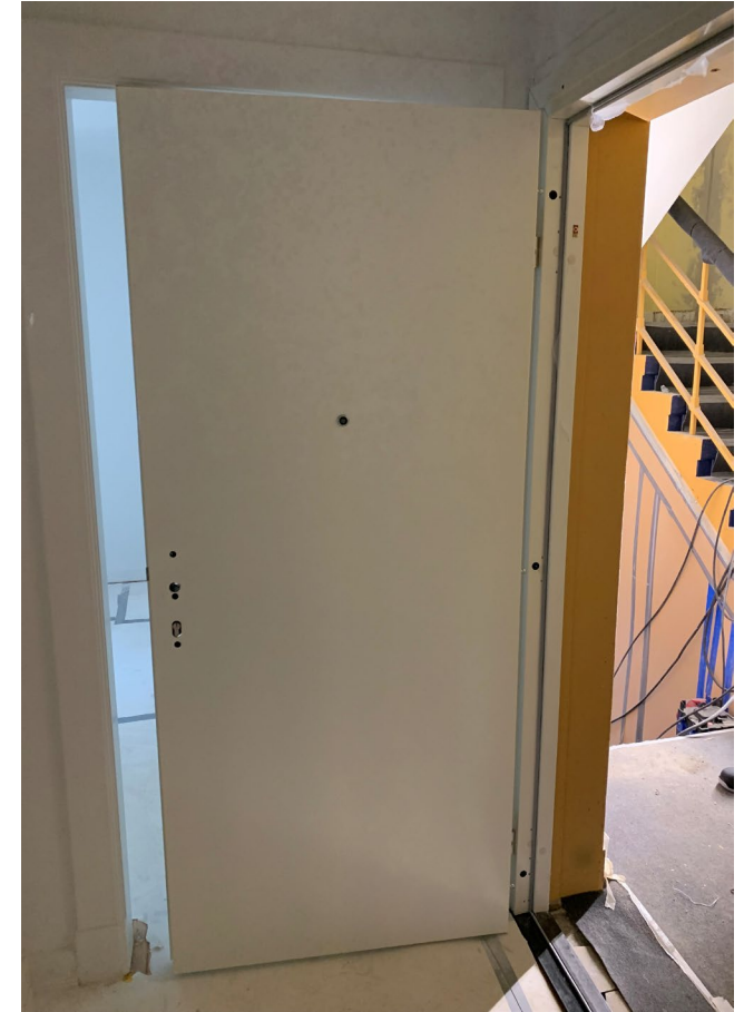
3. Daloc S43 Türblatt einhängen und Montage abschließen.
