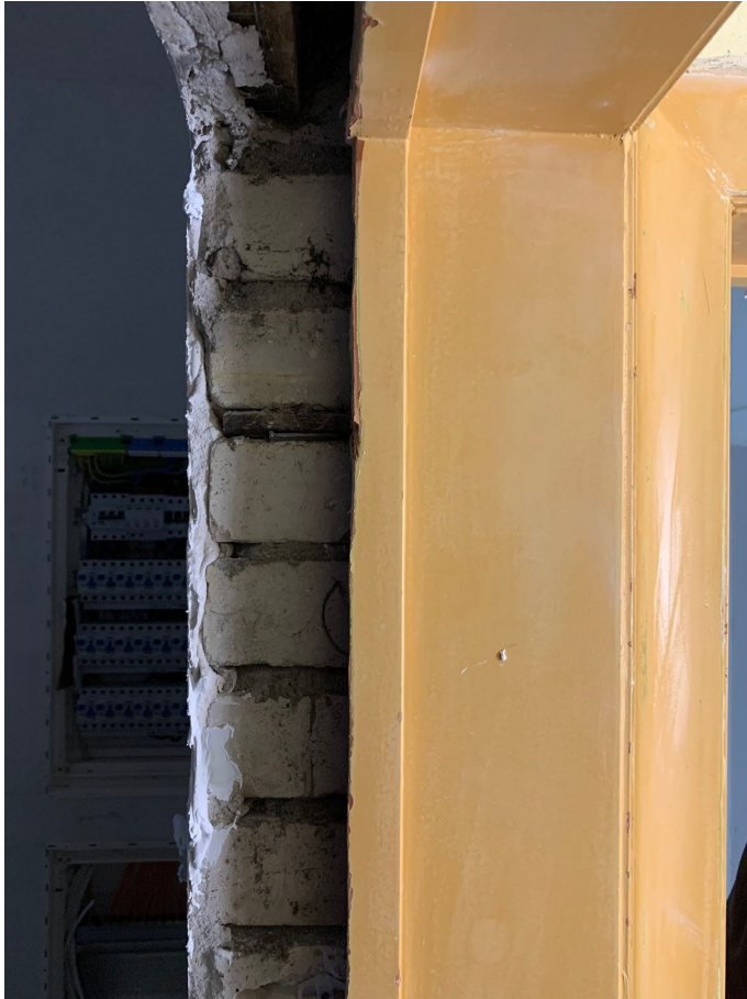
1. Innenseite der Holzzarge einschneiden.
