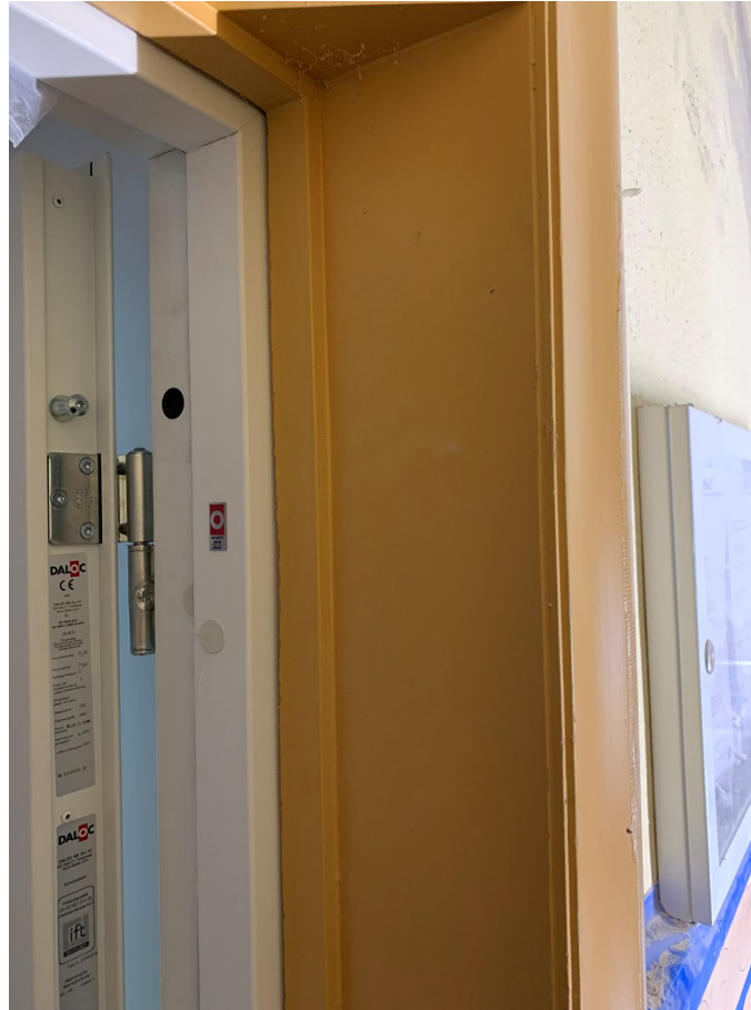
2. Daloc K41 Eckzarge von innen gegen die Holzzarge setzen.
